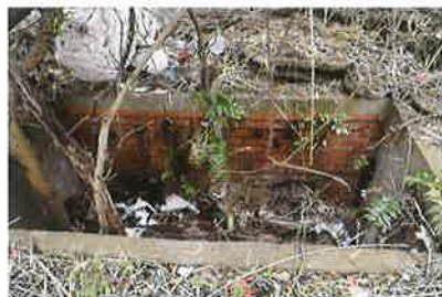
(写真11) カマドの焚口。煉瓦づくりで半地下構造となっている。
